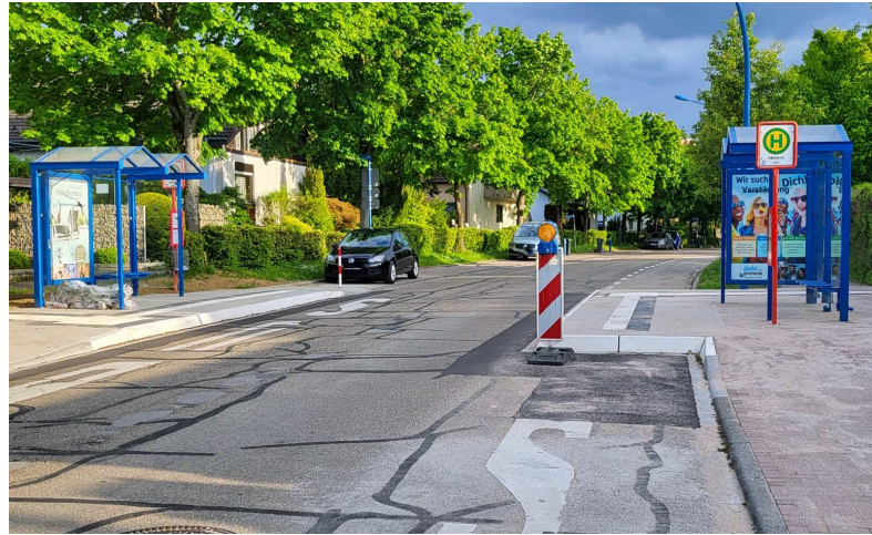
Barrierefreie Baustellen - Albtherme
