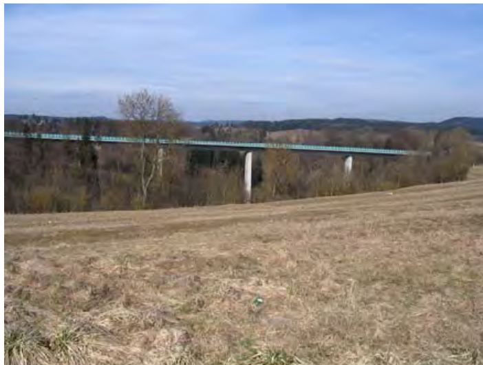
Neckarbrücke zur Aufnahme der Leitungstrassen
