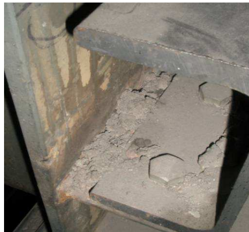
Abb. B.3_6. Mangelhafte Schweißnähte
