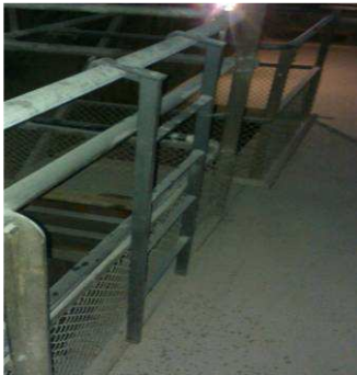
Abb. B.3_17. Die Wartungsleiter ist nicht gesichert.
