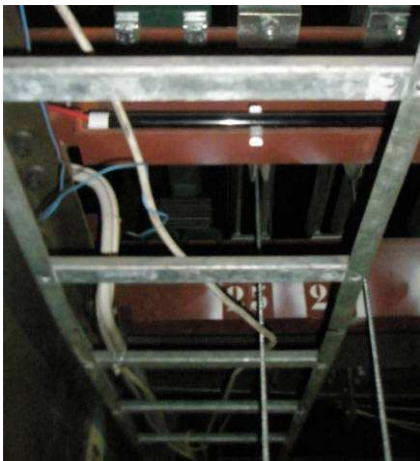
Abb. B.3_5. Seilablauf überschneidet sich mit Kabel- und Trassenverlauf
