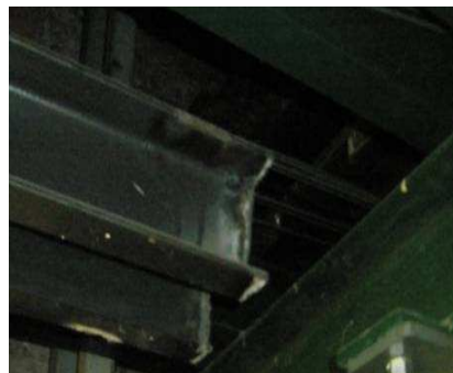
Abb. B.3_2. Träger wurden abgebrannt und nachträglich nicht verarbeitet
