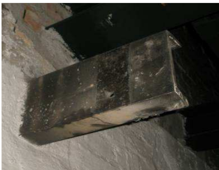
Abb. B.3_1. Unnötige Träger wurden nicht komplett zurück gebaut.
