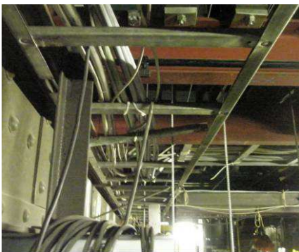
Abb. B.3_10. Die Elektrotrassen sind teilweise zu groß dimensioniert.
