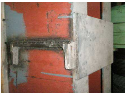
Abb. B.3_8. Nicht genutzte Stahlträger wurden nicht restlos zurück gebaut
