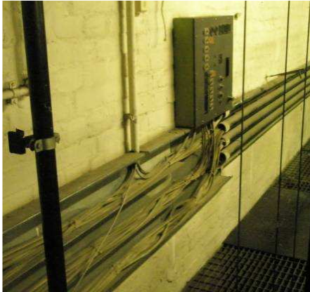
Abb. B.3_12. Die Elektrotrassen sind nicht geschlossen
