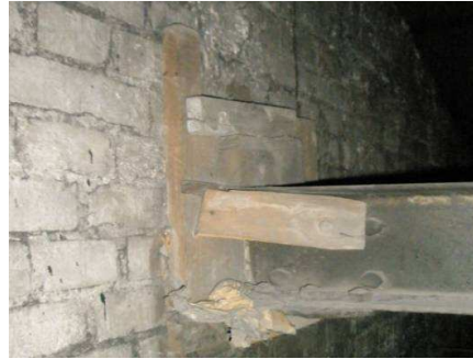
Abb. B.3_4. Schalungen sind nicht zurückgebaut worden
